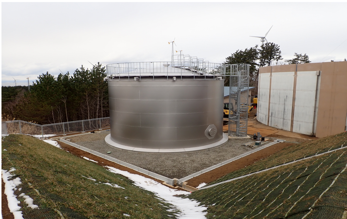
大間配水場新設配水池築造工事(令和 7 年 1 月竣工) ステンレス製円形型配水池(500 m 3 )
