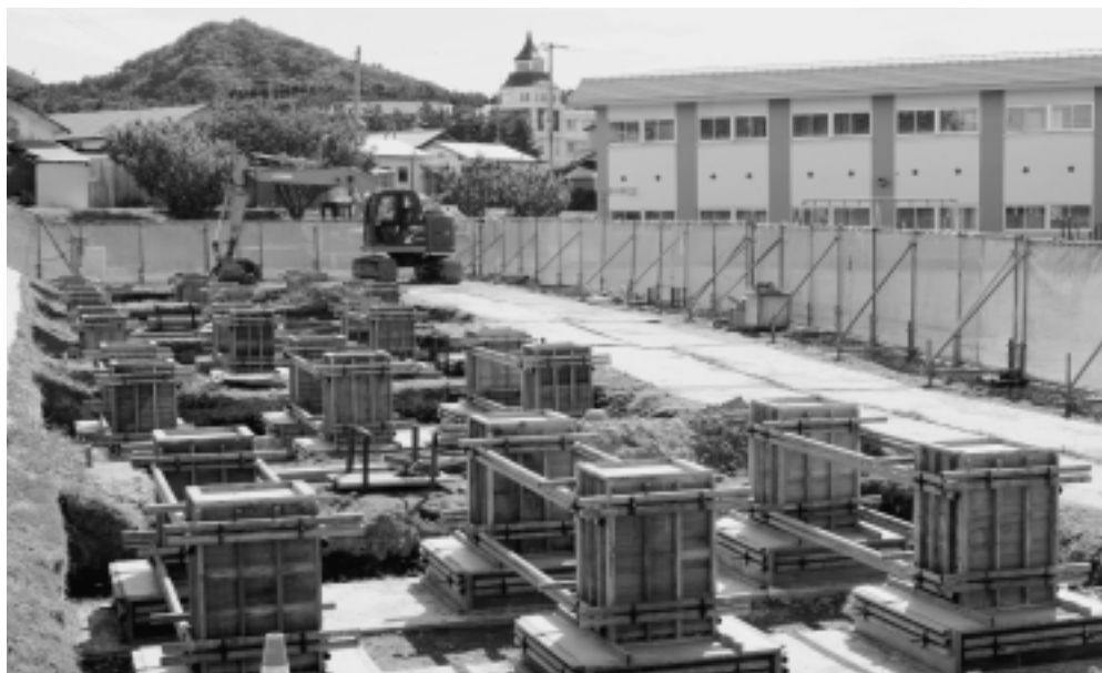
奥戸小の太陽光パネル設置工事
